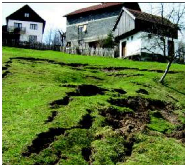
Slika broj 4 - Klizište
