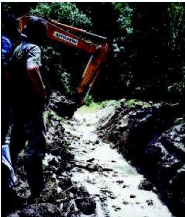
Izrada (mašinski kopanih) kanala, trenutak upoja značajnije površinske akumulacije vode
