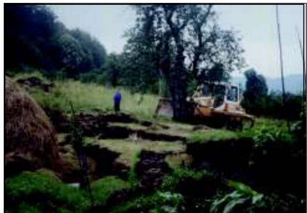
Planiranje terena uz zatvaranje otvorenih kliznih pukotina
